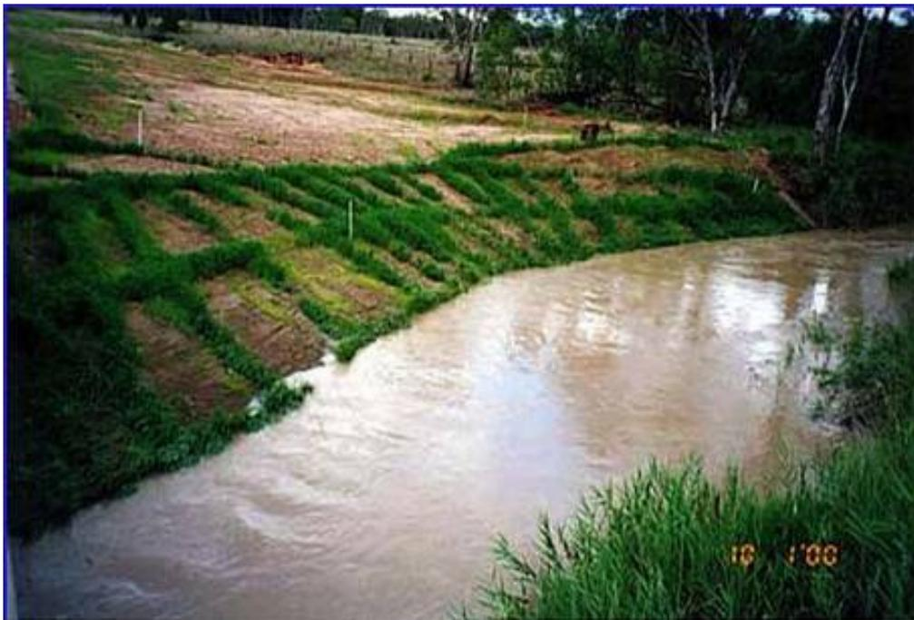
Figura 32 – Situação da margem do canal após um mês de implantado o vetiver.
