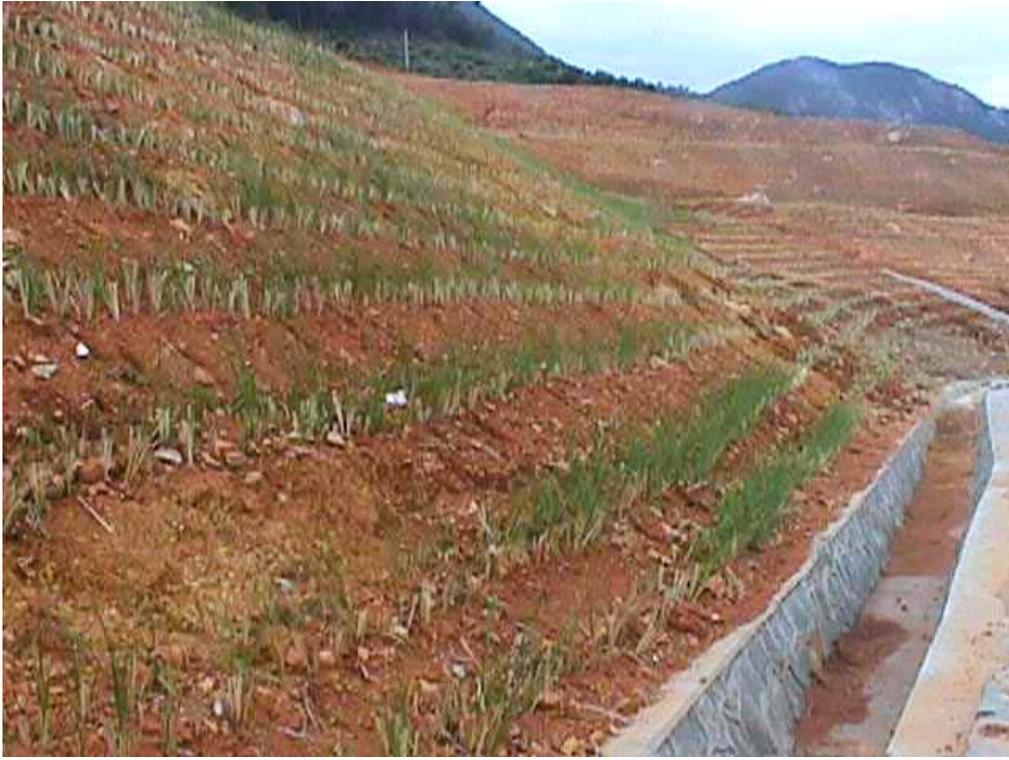
Figura 16 – Taludes de corte estabilizados com o sistema vetiver (China).
