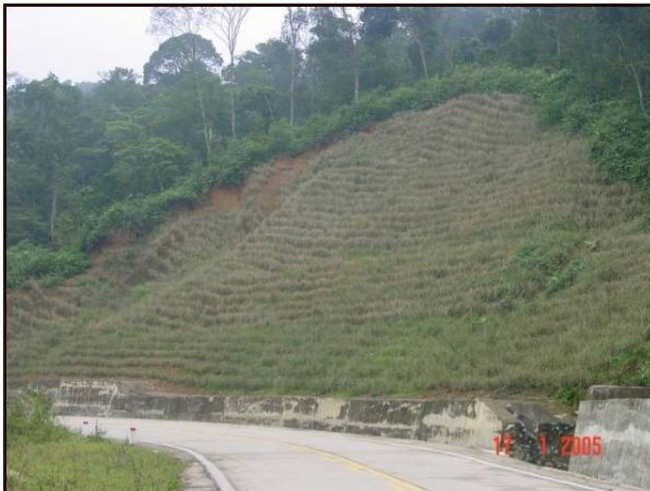
Figura 11 – Taludes de corte em situação semelhante à figura anterior, um ano após a implantação do capim vetiver. (Vietnã)
