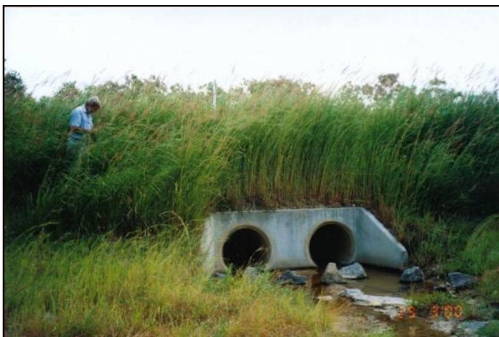
Figura 25 – Taludes da área de bueiro protegidos com capim vetiver após 8 meses do plantio. (Austrália)
