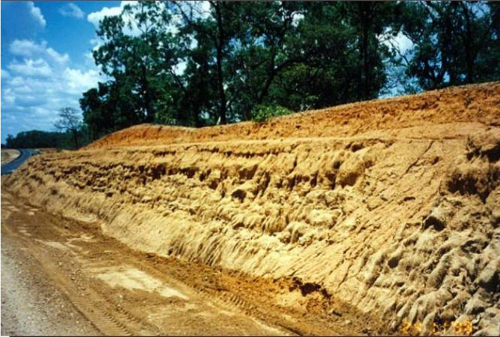
Figura 6 – Taludes de cortes ao longo de estrada onde a aplicação do vetiver é recomendada. (Austrália)
