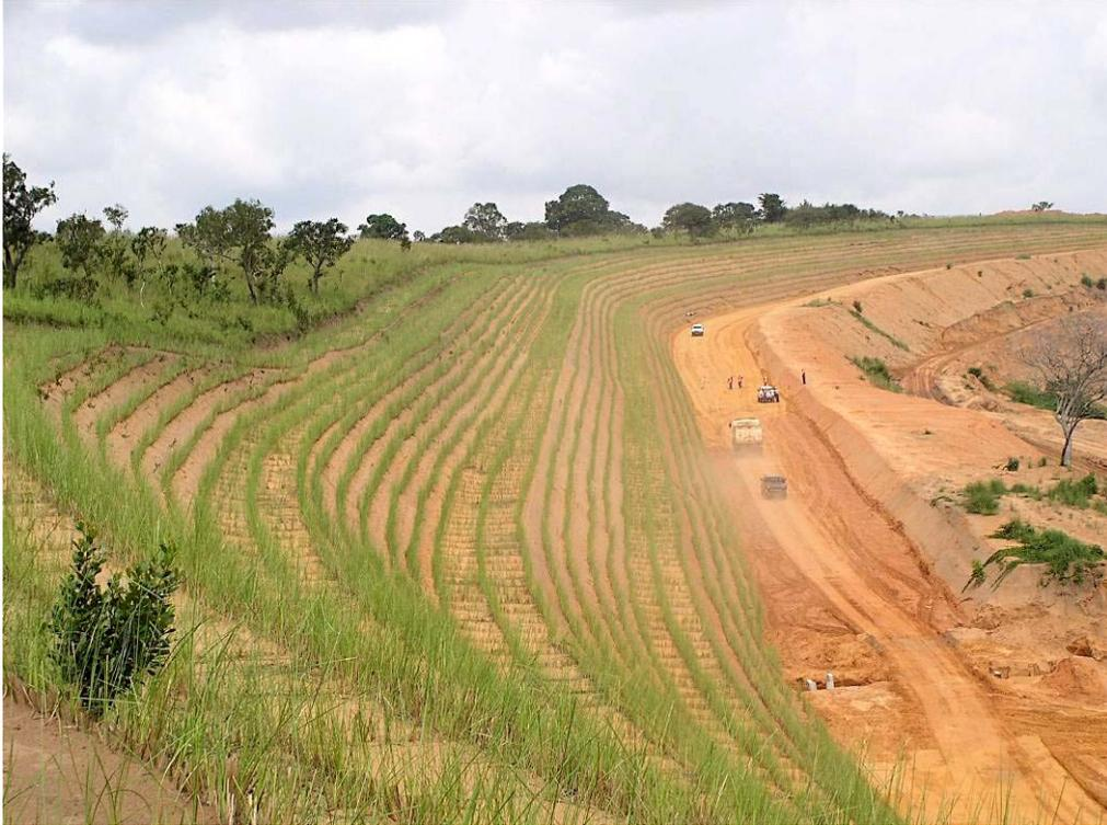
Figura 14 – Situação dos taludes de corte após três meses de implantado os cordões de vetiver (Congo).
