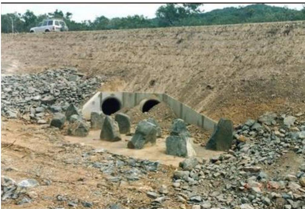
Figura 24 – Taludes de aterro íngremes na passagem de bueiro duplo antes da aplicação do capim vetiver (Austrália)
