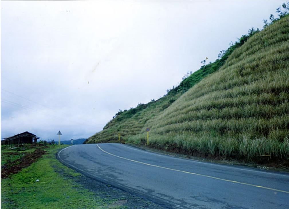
Figura 17 – Taludes de corte estabilizados com o sistema vetiver (Filipinas).
