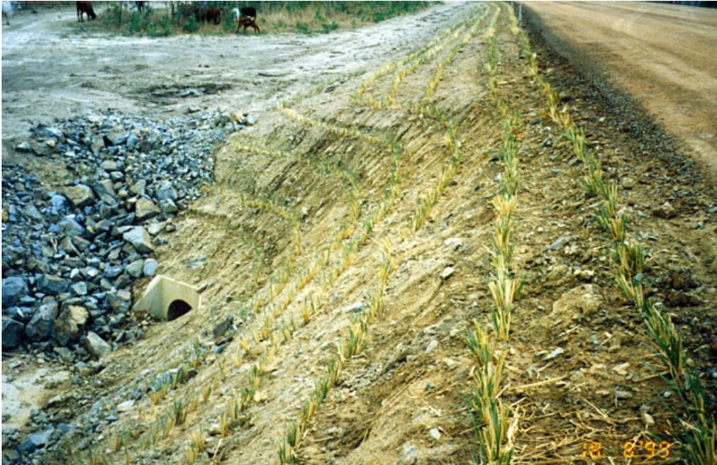
Figura 27 – Taludes de aterro, em area de travessia de bueiro, com linhas de vetiver implantadas para a proteção do talude contra processos erosivos (Austrália)
