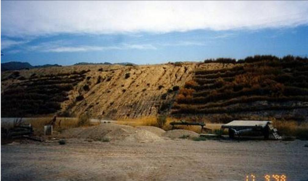
Figura 5 – Talude com e sem a aplicação do capim vetiver, Espanha.
