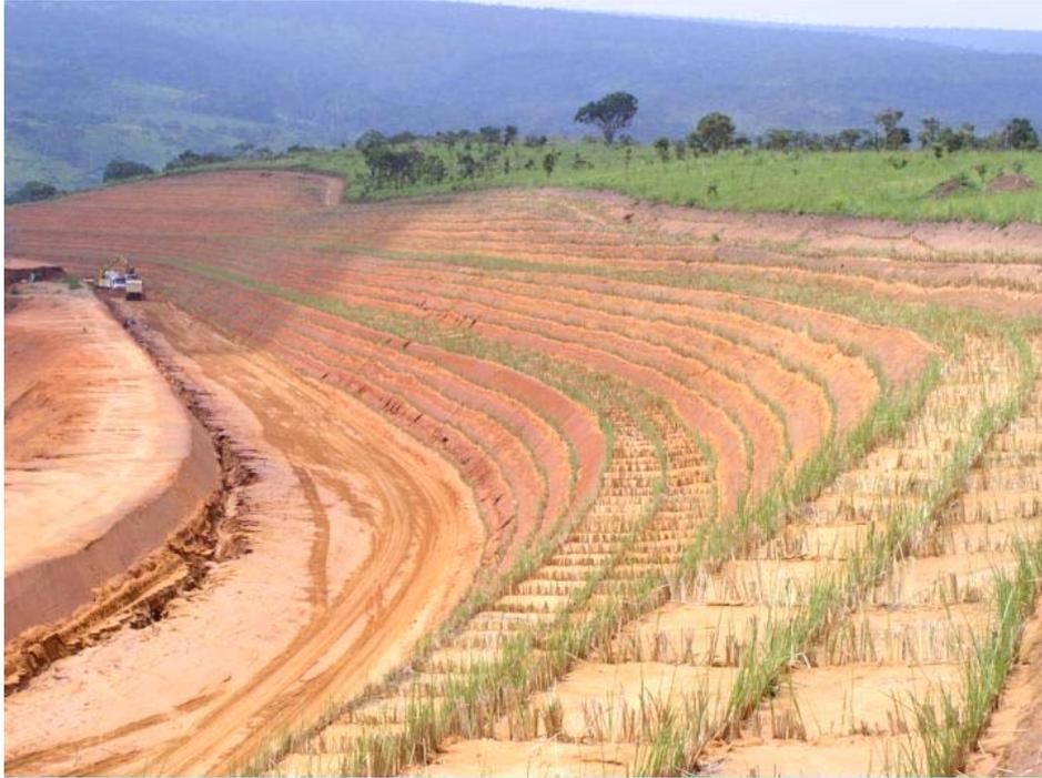
Figura 12 – Cordões de vetiver contornando os taludes de cortes e as bermas de uma rodovia em implantação no Congo.
