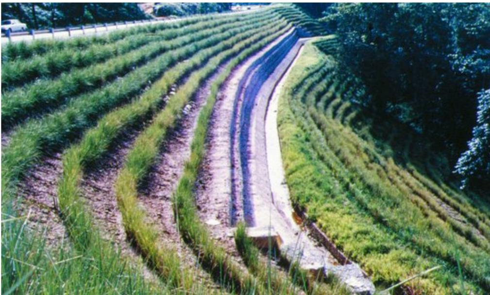
Figura 18 – Exemplo de uso do sistema vetiver na Malásia, na qual houve preocupação com a qualidade das plantas, bom domínio na aplicação, o acompanhamento e a supervisão adequada com manutenção.
