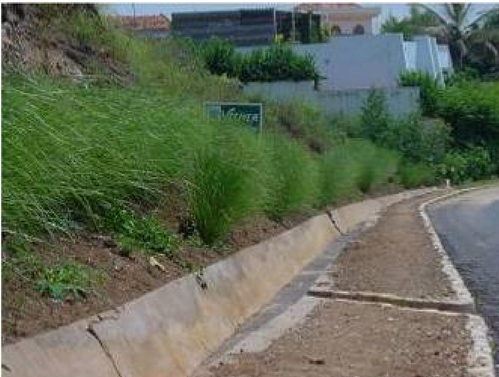
Figura 21 – Quatro meses após os taludes estão estáveis e o canal de drenagem protegido do assoreamento (setembro de 2001).
