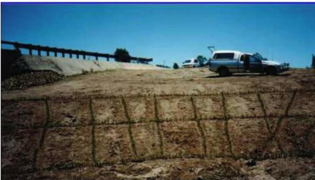
Figura 31 – Após retaludamentos as margens do canal sob a ponte recebeu linhas de vetiver plantadas em contornos que garantam a estabilidade do terreno, reduzindo a velocidade do fluxo de água.
