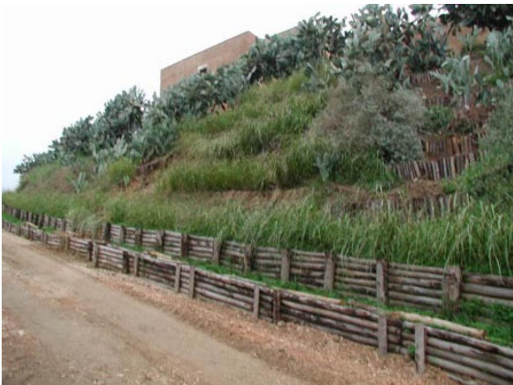
Figura 37 - Taludes, ao sul da Itália, protegidos com vetiver. O vetiver apresenta-se como reforço às estruturas de madeira que formam os terraços.
