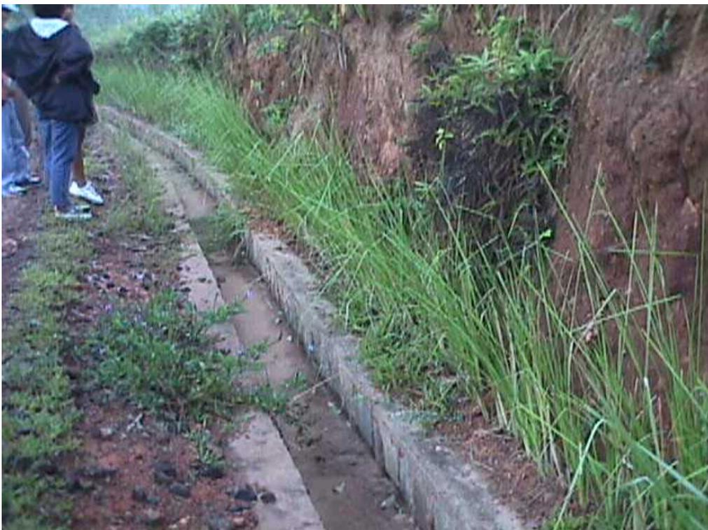
Figura 23 – Barreira de vetiver bordejando canaleta de drenagem evitando que sedimentos a bloqueiem. Observe como a canaleta esta limpa (Madagascar).
