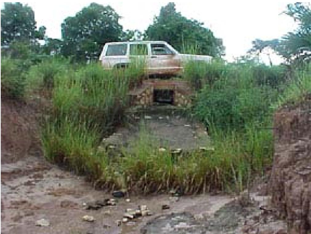
Figura 29 - O vetiver irá estabilizar este bueiro, e irá controlar o processo erosivo, reduzindo assim os custos manutenção (Madagascar)
