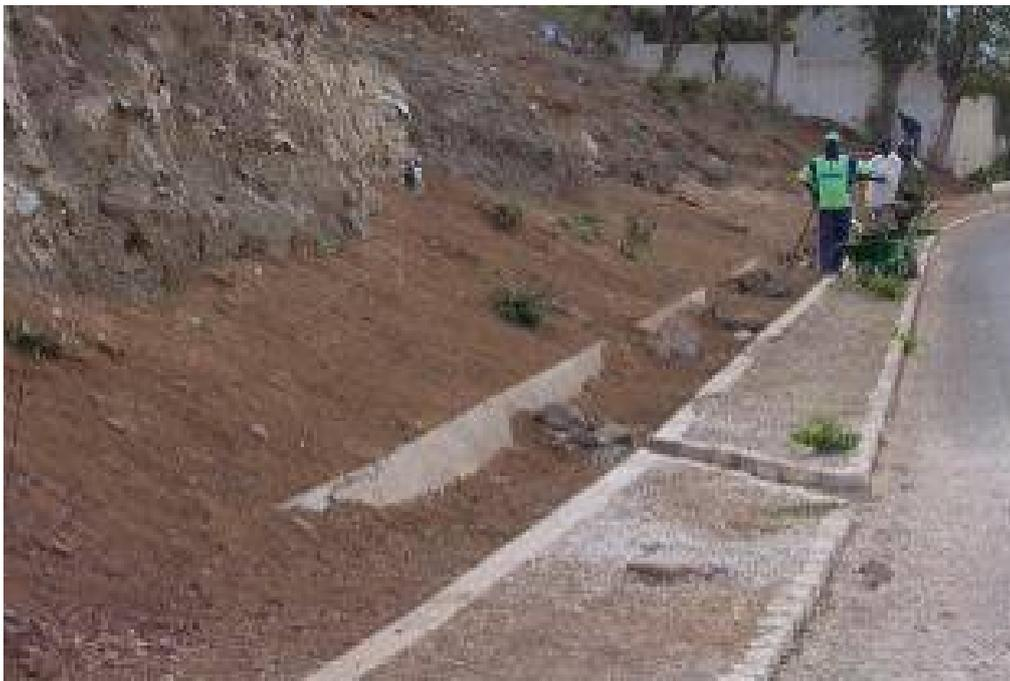
Figura 19 – Em maio de 2001, canal de drenagem completamente assoreado (maio de 2001) (Senegal)
