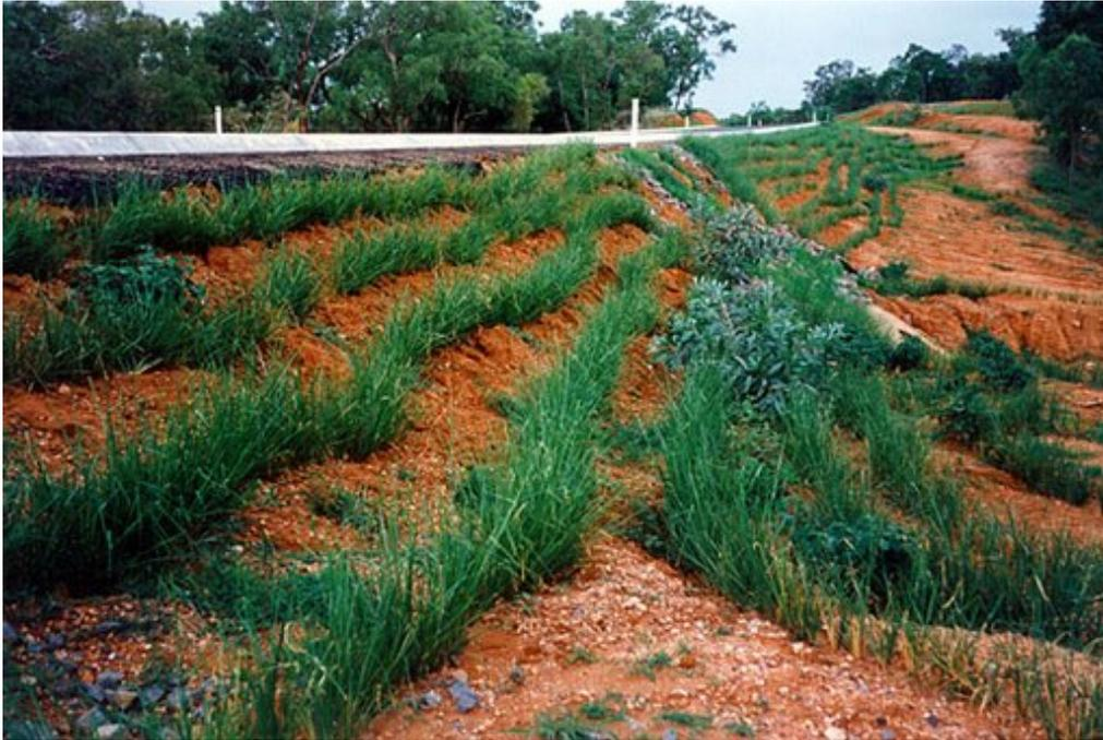
Figura 28 – Taludes protegidos por cordões de vetiver (Australia),
