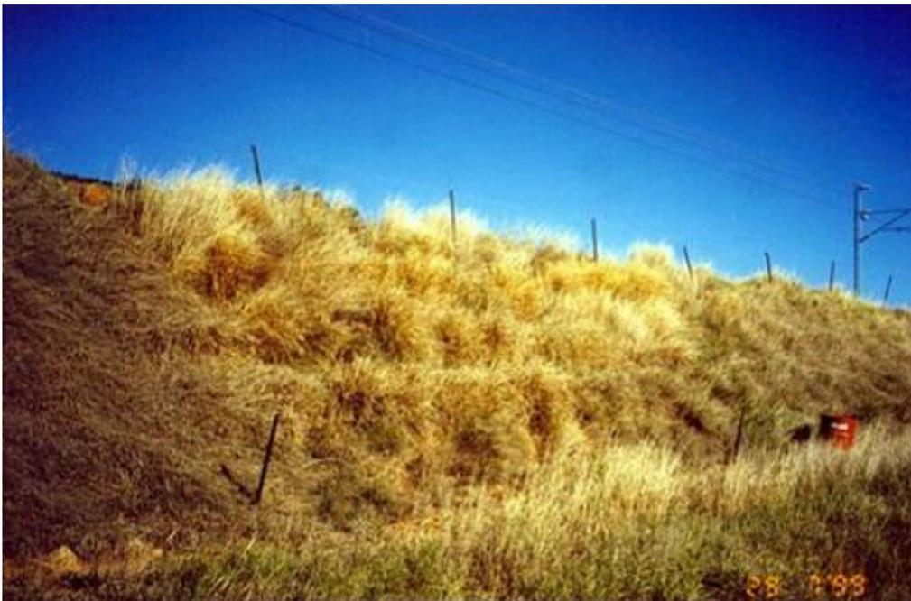
Figura 9 – Os mesmos taludes da figura anterior após uma ano do plantio do vetiver.
