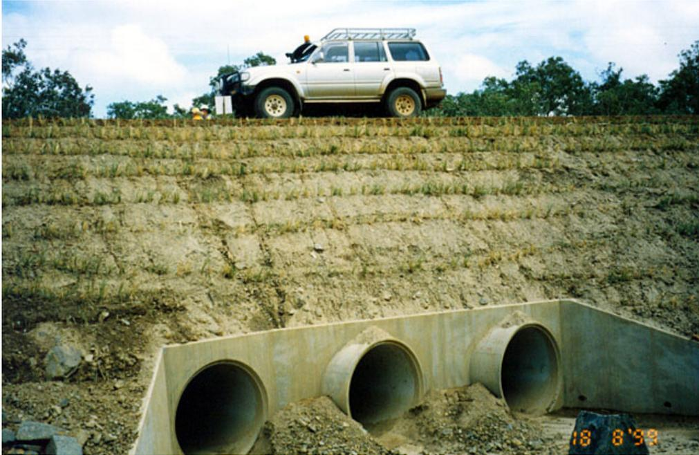
Figura 26 – Taludes de aterro na área de bueiro triplo, com linhas de vetiver implantadas (Austrália)
