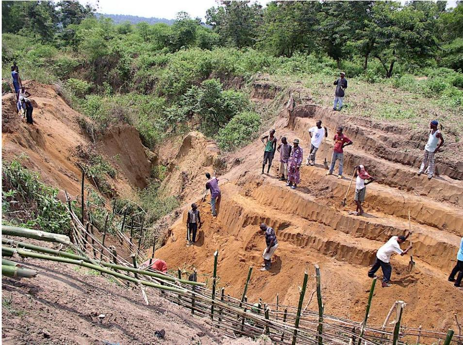
Figura 40 – Retaludamento manual formando degraus de forma a quebrar a velocidade de escoamento das águas de chuva e permitir o plantio do capim vetiver (Congo).
