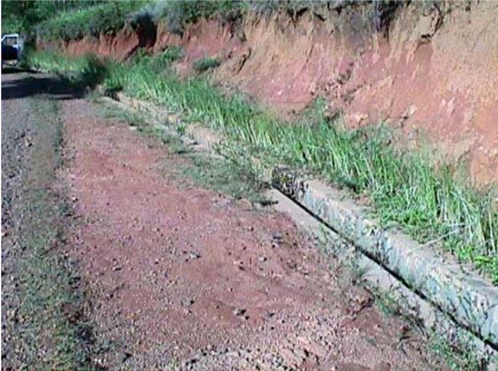
Figura 22 – A barreira de vetiver margeando a canaleta de drenagem irá melhorar a qualidade da águas no ponto final de lançamento e reduzir os custos de manutenção com limpeza (Madagascar)
