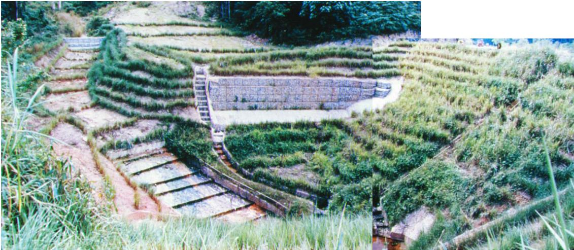
Figura 36 – Situação em uma das grandes rodovias da Malásia, onde o controle de maiores concentrações de água se faz com a combinação de estruturas de drenagens, muros de arrimos e a proteção dos processos erosivos com o uso do capim vetiver.
