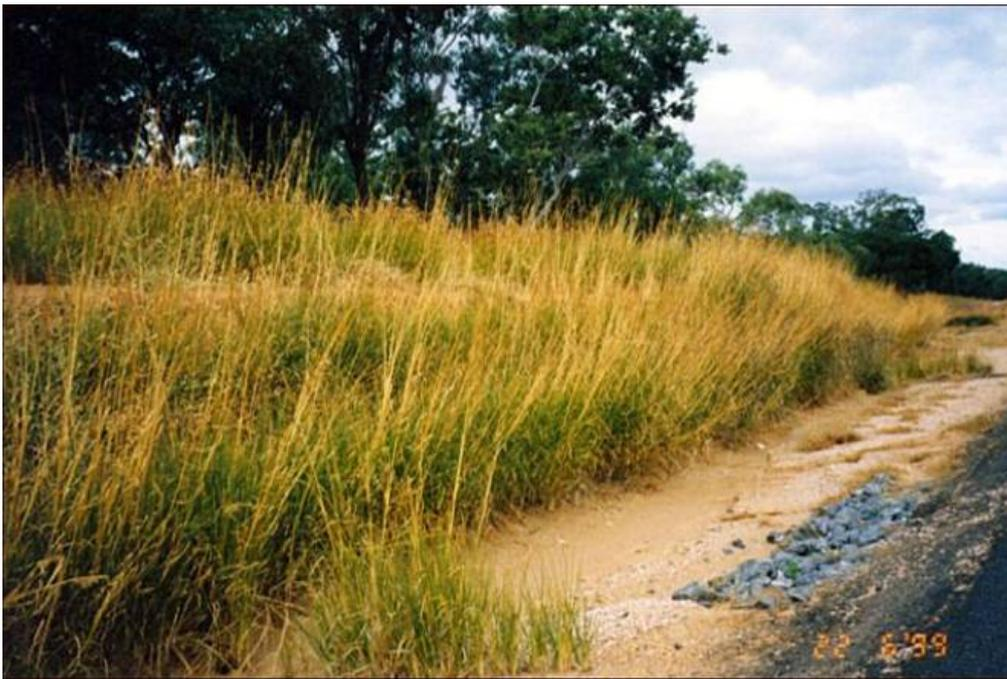
Figura 7 – Taludes às margens de rodovia com capim vetiver implantado há 10 meses. (Austrália).
