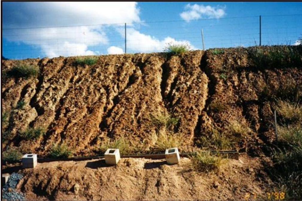
Figura 8 – Taludes à margem de rodovia antes da implantação do capim vetiver.
