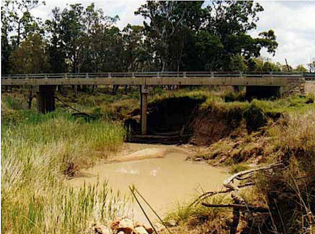
Figura 30 – Processos erosivos das margens do canal sob a ponte.
