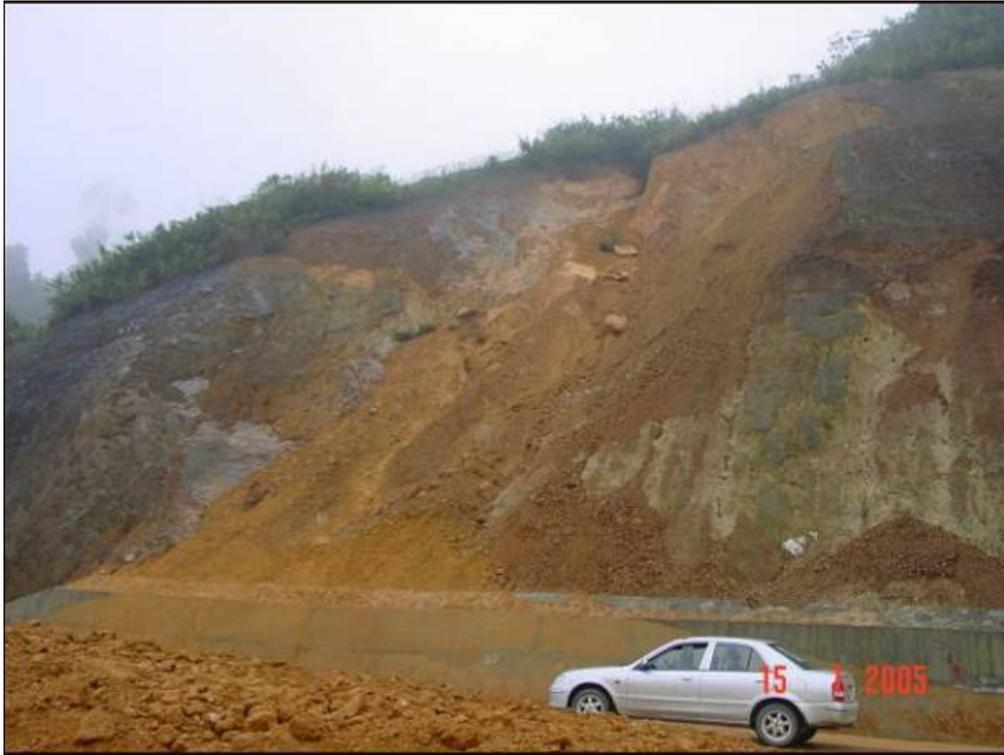
Figura 10 – Taludes de cortes instáveis antes da aplicação do sistema vetiver. (Vietnã)
