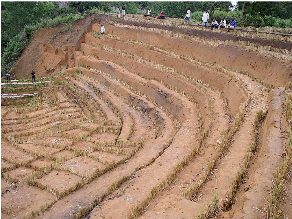
Figura 41 – Vista de parte da boçoroca com o capim vetiver já implantado (Congo).
