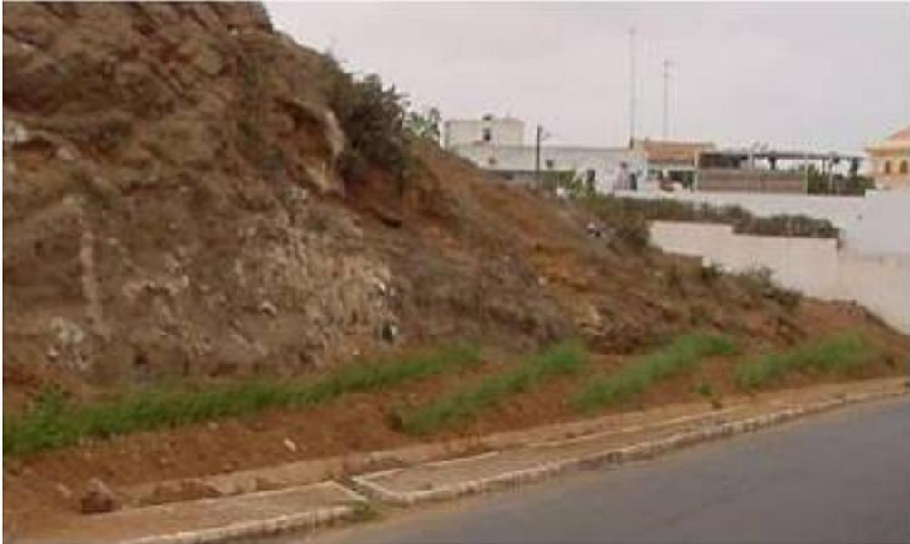
Figura 20 – Um mês após o plantio de barreiras de vetiver (junho de 2001).
